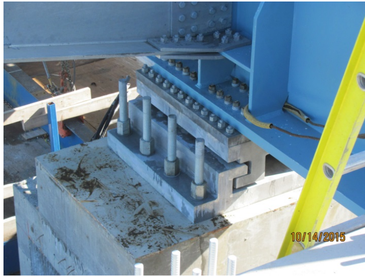
Figure 1-4 : Appareil d'appui centre-ouest en place. On aperçoit la plaque semelle biseautée entre l'aile de la poutre maîtresse et la plaque semelle de l'appareil d'appui.
